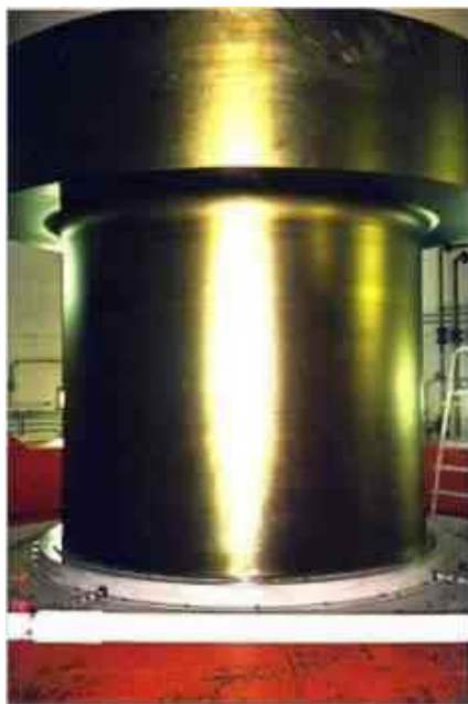
Subestação de Energia Elétrica isolada
